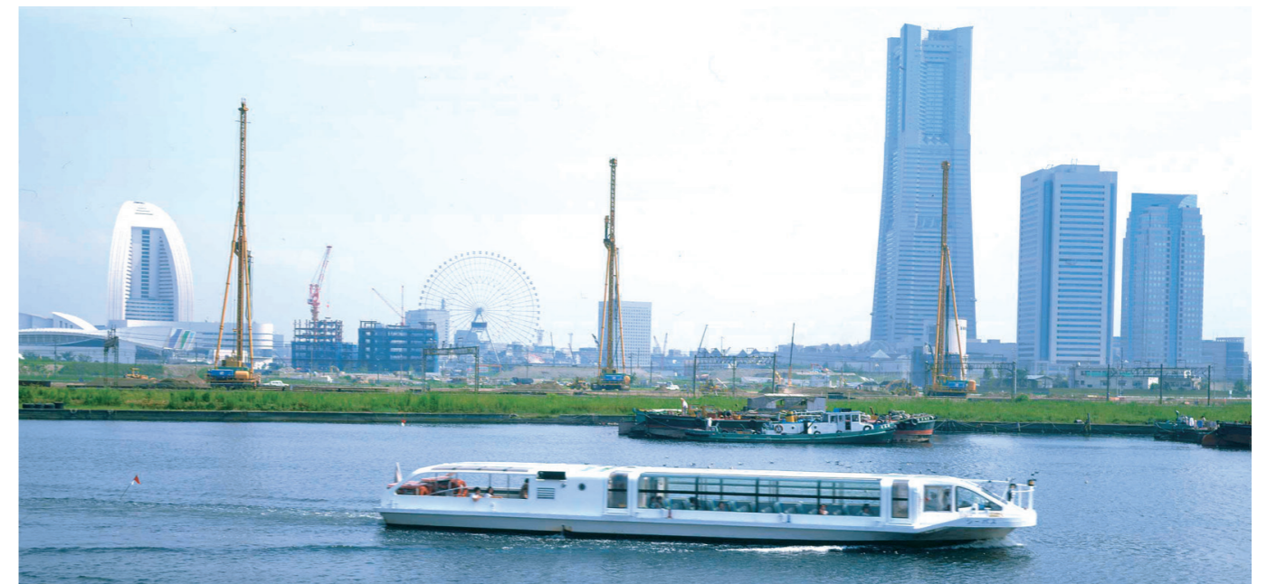
みなとみらい地区(横浜市)で施工するサンドドレーン施工機械
