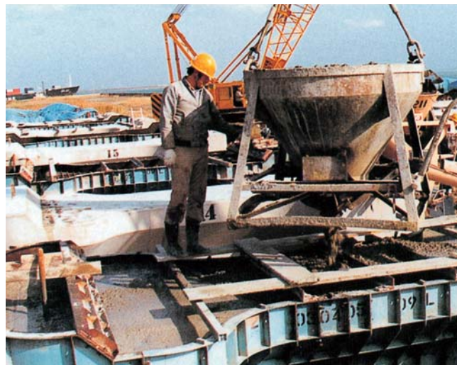
⑤コンクリート打設
