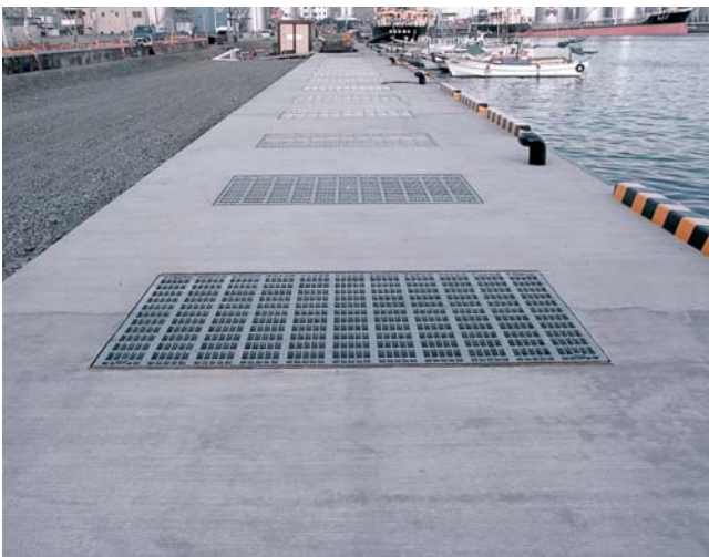
⑰グレーチング工
