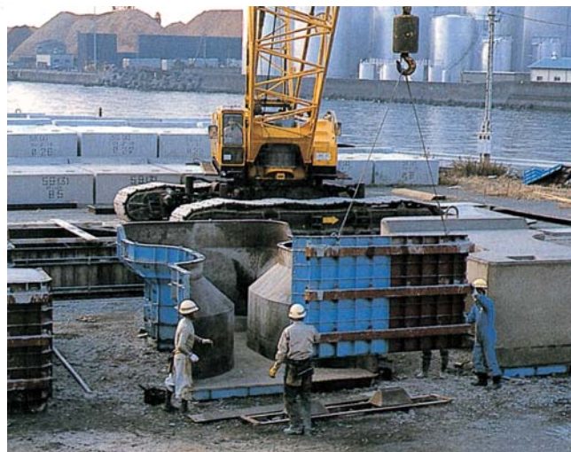
③型枠組立
