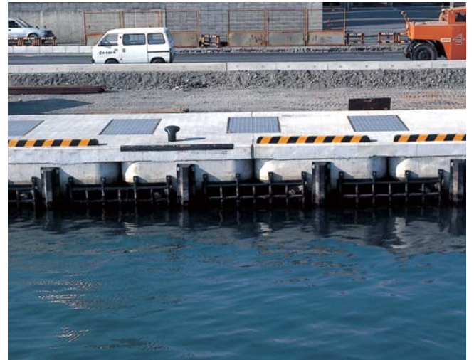
⑯係船柱、車止、防舷材、侵入防止フェンス
