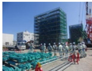
気仙沼地区下部工工事における現場研修
