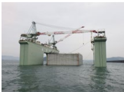
進水状況 (FDを沈下させた状況)
