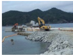
仮設道路の造成
