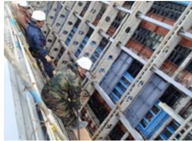
透明型枠を使用
