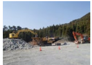
自走式破砕機による作業
