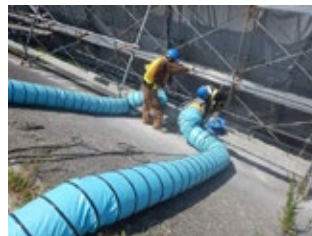
送風機を使用して削孔時に発生する粉塵の飛散を防ぐ
