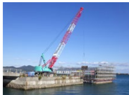
海上打継場での施工
