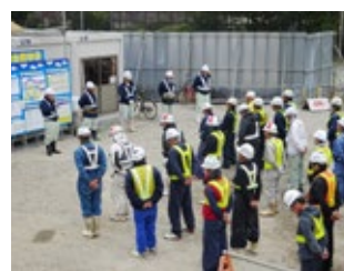
新東名高速道路 伊勢原高架橋他2橋(下部工)における安全訓話
