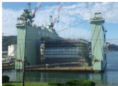
FDでの施工
