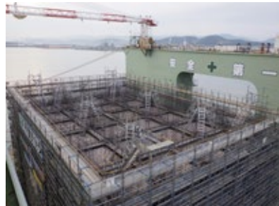
安全な足場の設置
