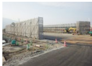
防塵ネットフェンスで施工範囲を囲う
