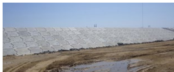
真野川漁港海岸に採用されたクラブブロックE型
