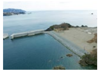
被覆石護岸の完成
