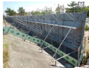
枠組足場に防音シートを設置
