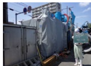
防音マットと防音シートを設置
