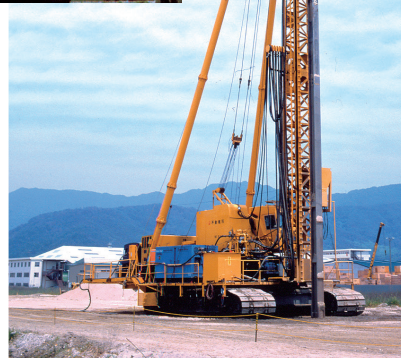
KFコンパクション工法
