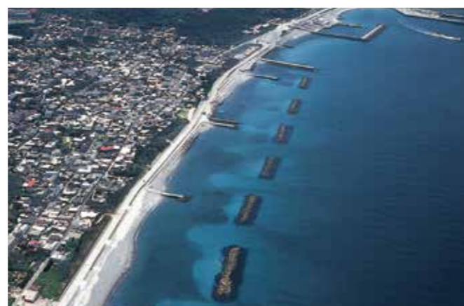
新島港海岸(東京都) 事業主体:東京都 施設名:離岸堤 備考:港湾海岸
