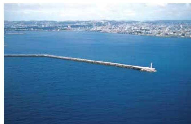
那覇港(沖縄県) 事業主体: 内閣府沖縄総合事務局 施設名: 新港第1防波堤
