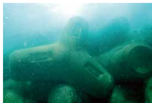
設置直後のイオンカルチャープレート付き溝付きテトラポッド
