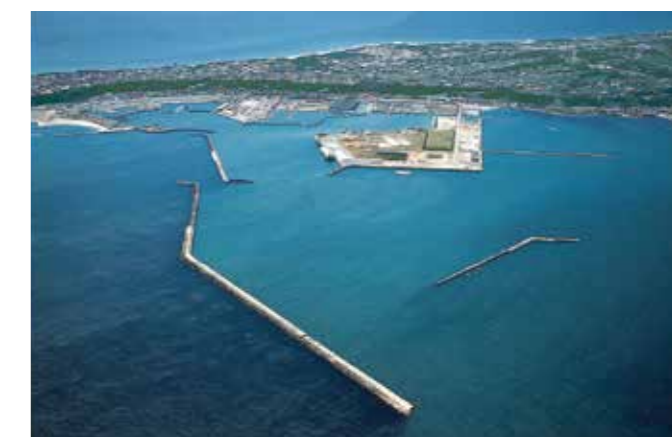
御前崎港(静岡県) 事業主体: 国土交通省中部地方整備局 施設名: 沖防波堤
