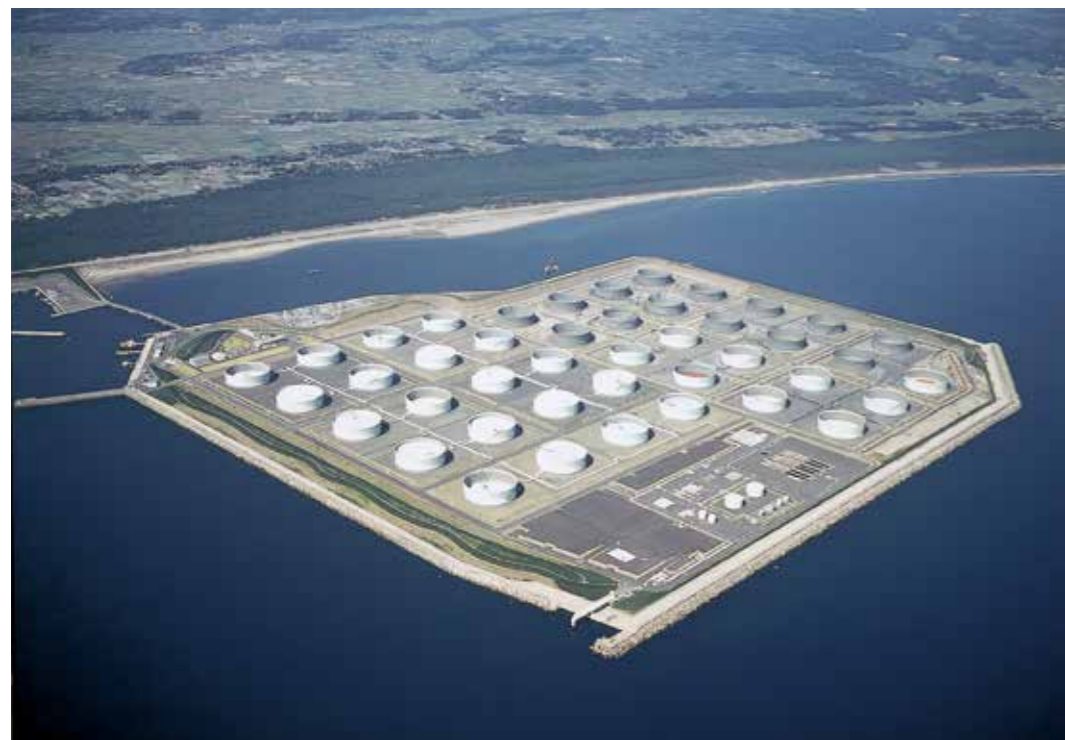
志布志石油備蓄基地(鹿児島県) 事業主体: 志布志石油備蓄(株) 施設名: 埋立護岸
