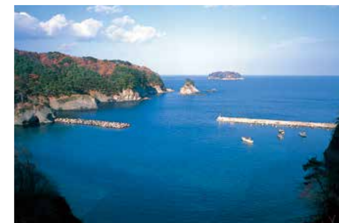
蛸の浜漁港(岩手県) 事業主体: 岩手県宮古市 施設名: 北防波堤
