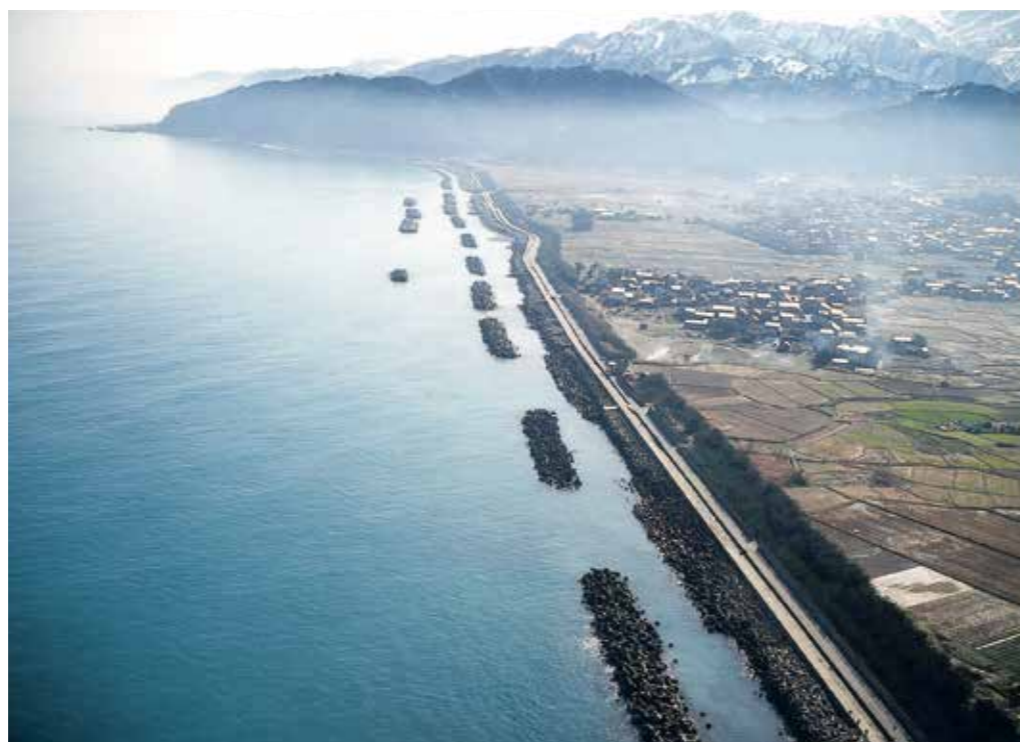
下新川海岸(富山県) 事業主体:国土交通省北陸地方整備局 施設名:離岸堤 備考:建設海岸
