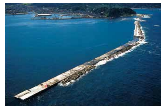
輪島港(石川県) 事業主体: 国土交通省北陸地方整備局 施設名: 防波堤
