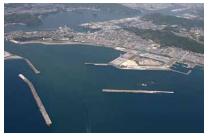
高知新港(高知県) 事業主体: 国土交通省四国地方整備局 施設名: 南防波堤、東第一防波堤 出典: 高知県土木部港湾・海岸課ホームページ
