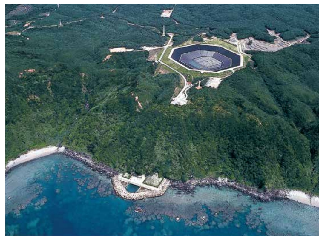
沖縄やんばる揚水発電所 (沖縄県) 事業主体:電源開発(株) 施設名:放水口前面の消波堤
