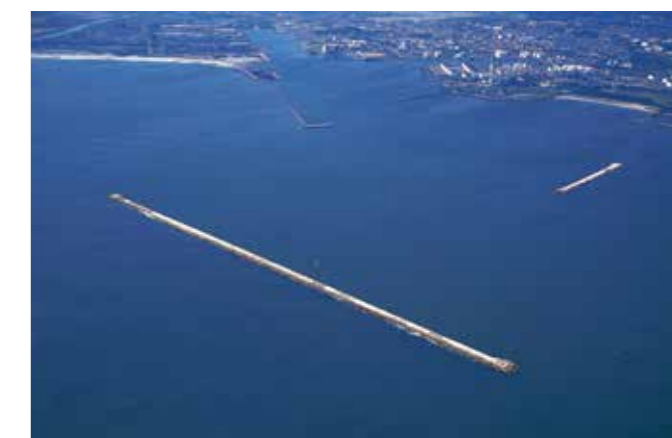
仙台港(宮城県) 事業主体: 国土交通省東北地方整備局 施設名: 沖防波堤 事業主体: 宮城県 施設名: 新北防波堤
