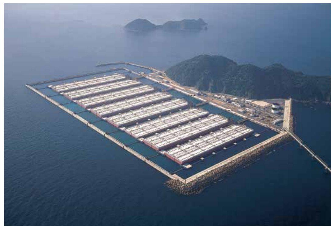
北九州港 白島地区(福岡県) 事業主体: 国土交通省九州地方整備局 施設名: 北護岸 事業主体: 白島石油備蓄(株) 施設名: 北防波堤 備考: 背後は白島石油備蓄基地
