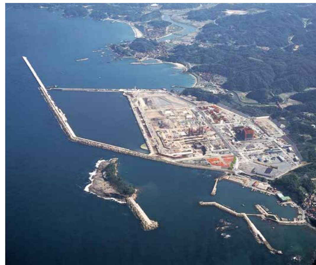
三隅火力発電所(島根県) 事業主体:中国電力(株) 施設名:防波堤、護岸
