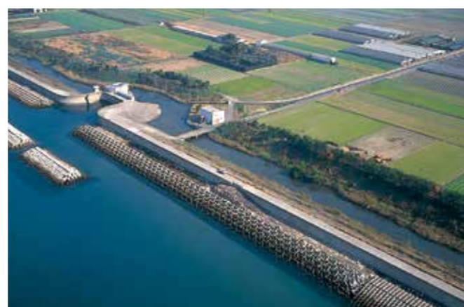
三豊干拓(香川県) 事業主体:香川県 施設名:防潮堤 備考:農地海岸
