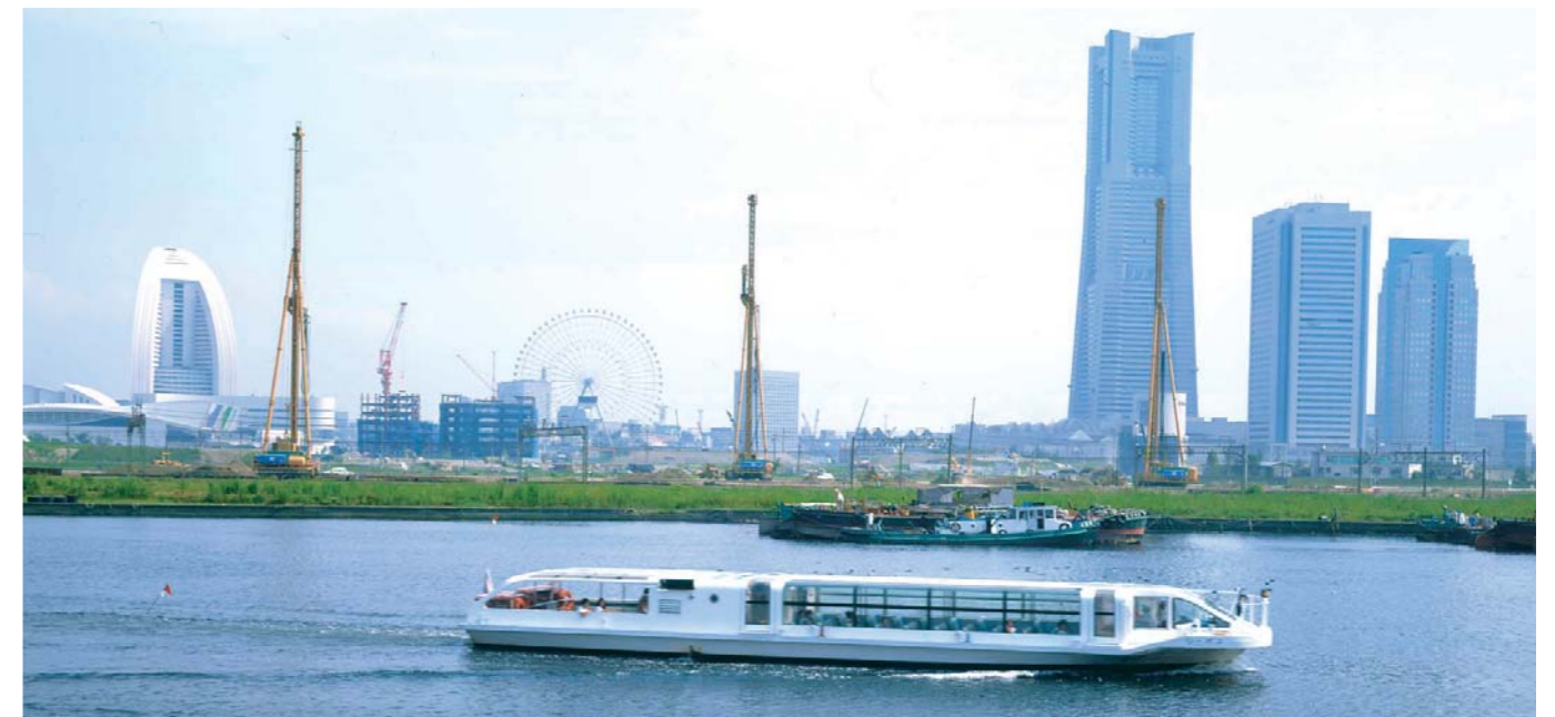
みなとみらい地区(横浜市)で施工するサンドドレーン施工機械
