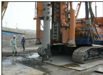
杭芯確認・ケーシングセット
