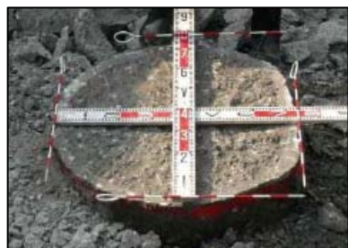
固化杭出来形確認
