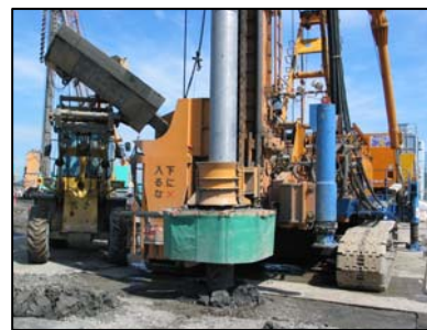
施工機械へ材料投入
