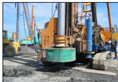
固化杭造成(ウェーブ施工*)
