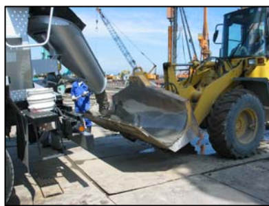
コンクリート搬入 (リサイクル材も使用可)
