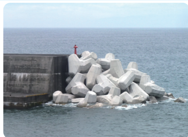
事業主体：東京都 施設名：野増漁港 防波堤 施工年度：平成26～30年度 トン型：100t型 (堤頭部)・65t型 (堤幹部)
