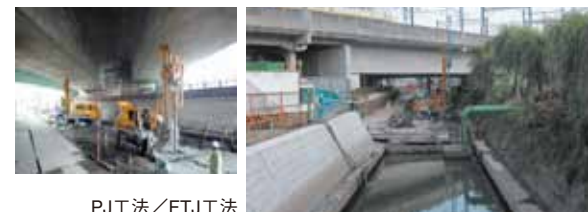
PJ工法/FTJ工法
