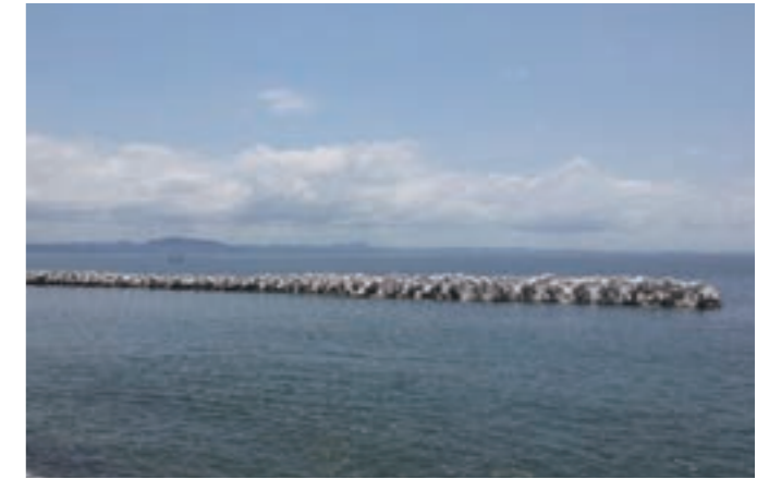
きたしたうら 北下浦漁港海岸 (神奈川県) 施工場所: 神奈川県横須賀市 事業主体: 横須賀市 施設の種類: 離岸堤 トン型: 20t型
