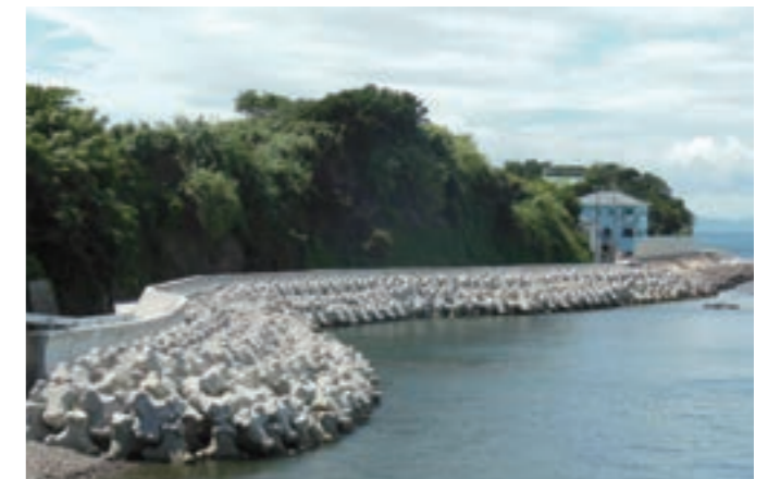
せんしゅう 泉州海岸 (大阪府) 施工場所: 大阪府泉佐野市 事業主体: 大阪府 施設の種類: 防潮堤 トン型: 4t型
