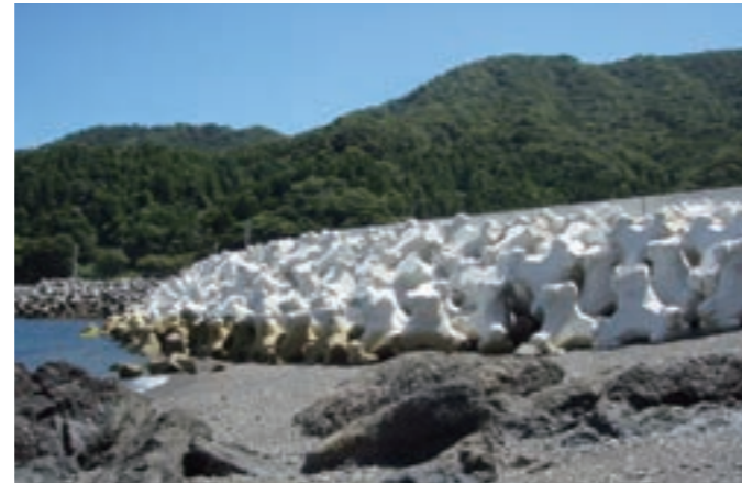
ひがしあかき 東深江漁港 (大分県) 施工場所: 大分県臼杵市 事業主体: 大分県 施設の種類: 護岸 トン型: 4t型
