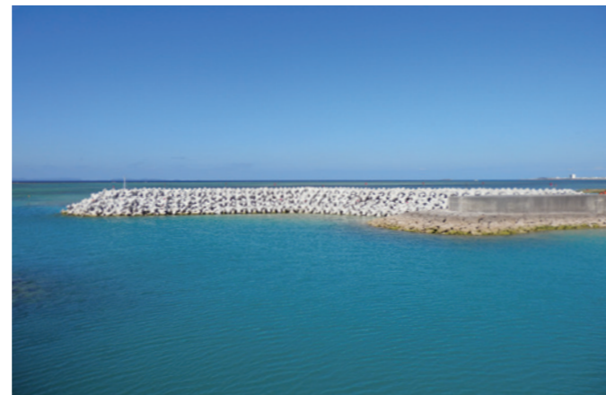
きやん 喜屋武漁港 (沖縄県) 施工場所: 沖縄県糸満市 事業主体: 糸満市 施設の種類: 防波堤 トン型: 2t型
