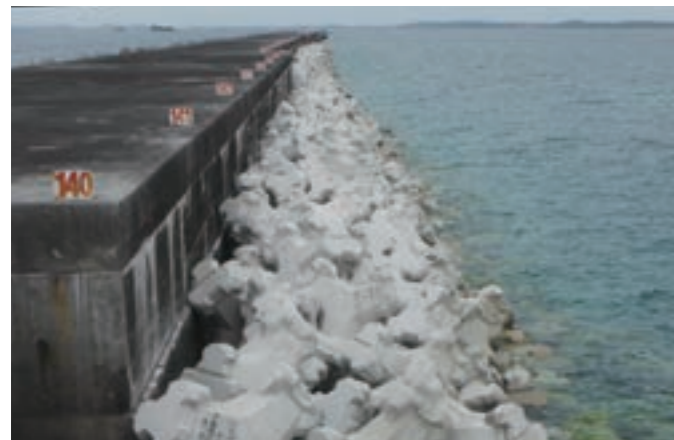
ひらら 平良港 (沖縄県) 施工場所: 沖縄県宮古島市 事業主体: 沖縄総合事務局平良港湾事務所 施設の種類: 防波堤 トン型: 4t型
