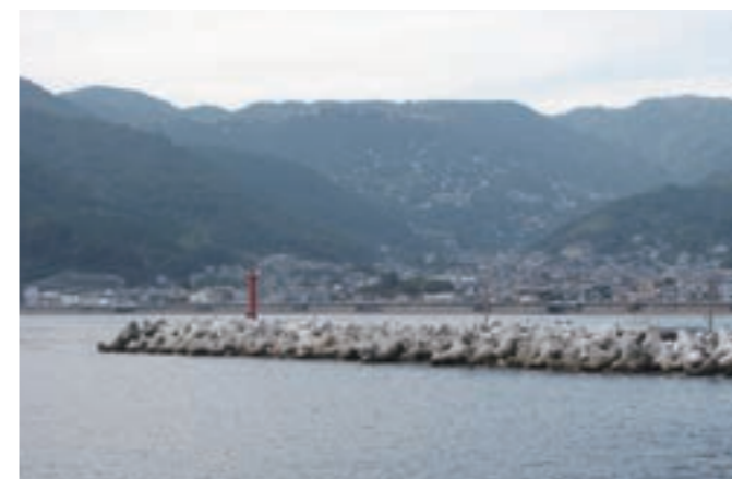
うさみ 宇佐美漁港 (静岡県) 施工場所: 静岡県伊東市 事業主体: 伊東市 施設の種類: 防波堤 トン型: 20t型
