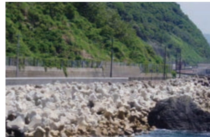
ごぼうがだい 午房ヶ平道路護岸 (福井県) 施工場所: 福井県越前町 事業主体: 福井県 施設の種類: 護岸 トン型: 12t型
