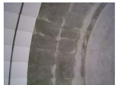
EPSパネル撤去後のコンクリート表面(湿潤状態)
