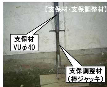
②脚部よりEPSパネルを建て込み、支保材をパネル中央の溝に設置
