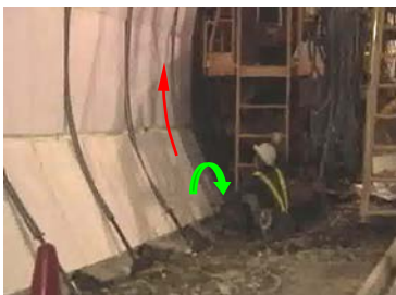
④支保調整材(棒ジャッキ)を伸ばしてEPSパネルを覆工面に密着
