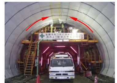
③天端用EPSパネルを建て込む
