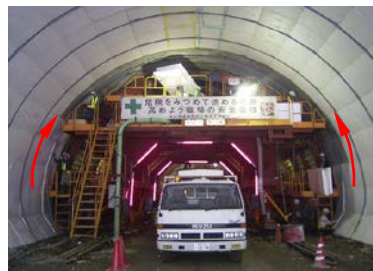
②脚部よりEPSパネルを建て込み、支保材をパネル中央の溝に設置
