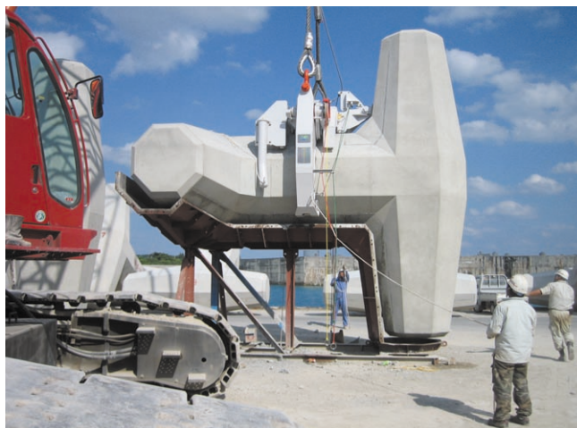
転置は専用吊具を用いて行います
