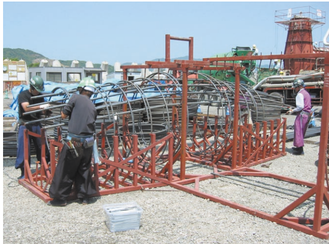
鉄筋組立は架台を用いて行います
