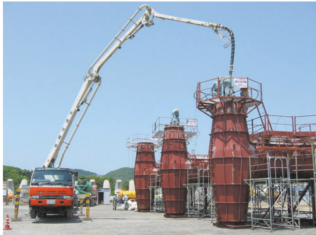
写真はポンプ車を用いた例です
