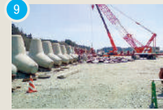
9 平井賀漁港北防波堤災害復旧応急工事 【工期】2011/11～2012/2
