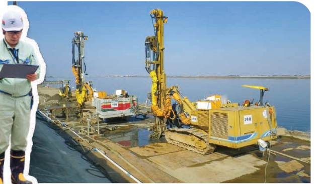
令和元年度 木曾川赤地川表高潮堤防補強工事(SAVE-SPI工法)
