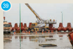
39 新北防波堤災害復旧工事 【工期】2012/5～2012/9
