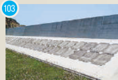
103 名洗港海岸高潮対策工事(名洗港堤防工)(工事件数:4件) 【工期】2018/11～2016/10
