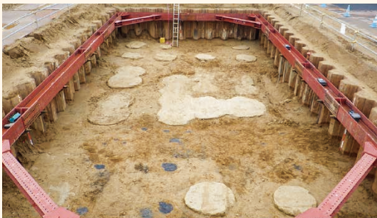
試験土槽内の改良体確認状況
