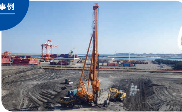
常陸那珂火力発電所 産業廃棄物最終処分場 埋立地管理業務委託工事 (サンドコンパクションパイル工法)
