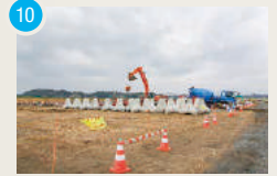
10 名取川太子堂地区護岸災害復旧工事 【工期】2011/11～2012/2
