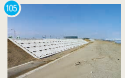
105 海岸基盤整備(復興)工事(工事件数:6件) 【工期】2015/10～2019/7
