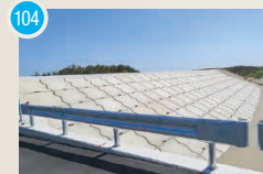
104 栗山川漁港農山漁村地域整備交付金工事(ブロック製作) 【工期】2019/9～2019/12
