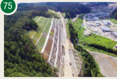
75 国道45号 南三陸地区道路 改良工事 【工期】2014/10～2016/8
