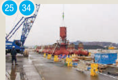
25 宮古港藤原地区外防波堤災害復旧工事 【工期】2012/3～2012/6 他1件工事
