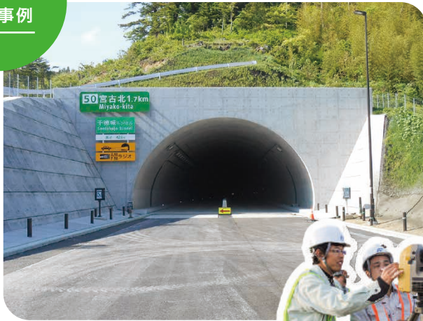
国道45号 千徳地区道路工事
