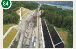
84 国道45号 野田地区道路改 良工事 【工期】2018/11～2021/3
