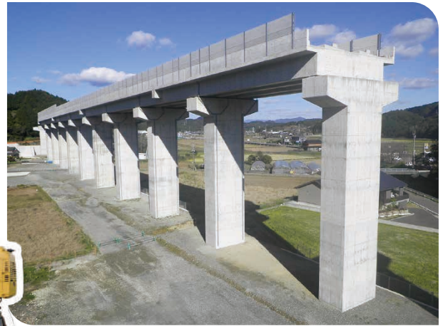
九州新幹線(西九州)袴野橋りょう他
