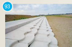
93 大洗海岸階段ブロック製作工事(工事件数:4件) 【工期】2014/9～2016/2
