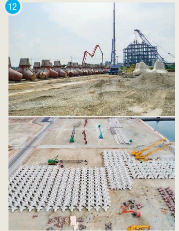
12 相馬港沖防波堤災害復旧工事 【工期】2011/11～2012/2
