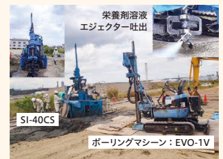
超小型の原位置浄化工法(シアンバイオ処理)
