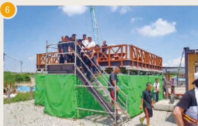
現場見学会の実施 (鳴瀬川野蒜水門災害復旧工事)
