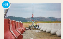
69 真野川漁港災害復旧工事(北防) 【工期】2013/2～2013/6
