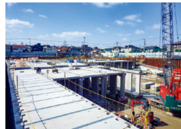
貯留施設の施工
