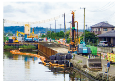
CI-CMC工法による護岸工事
