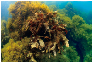
石川県蛸島漁港「テトラネオ」 設置約3年6ヶ月後 表面に海藻類(主にクロメとホンダワラ類)が高密度に着生
