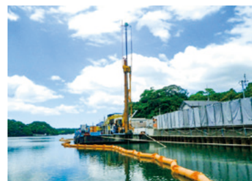
FTJ工法による海岸高潮対策
