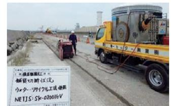
ウォーター・リサイクル工法による舗装切断状況
