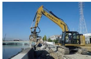
油圧圧砕機による取り壊し
