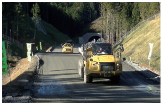
重ダンプトラックによる土砂運搬
