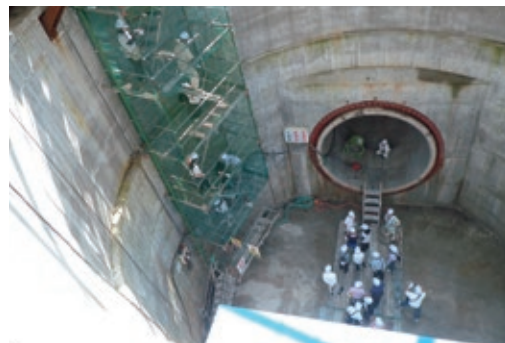
シールド管渠坑内を歩く
