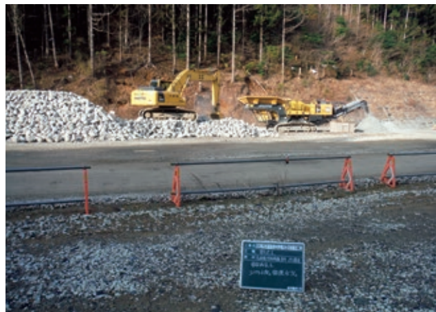
再資源化したコンクリートガラを路床の盛土材に再利用
