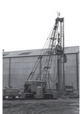
バイブロ（振動）方式の施工機
