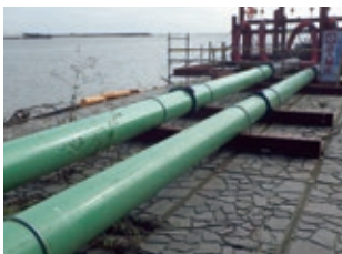
配管によるバイパス
