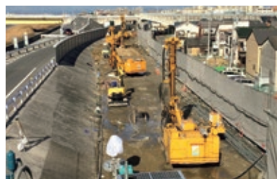
SAVE-SP工法(河川堤防 基礎地盤の液状化対策)
