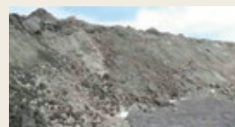
排出土を盛土に転用
