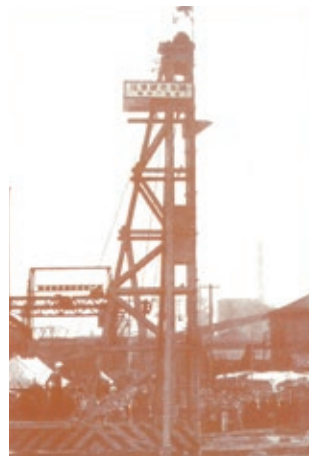
圧密砂杭工法の初公開実験
