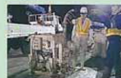
コンパクトな注入管リフト装置
