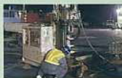
削孔スライムもすべて回収
