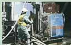
ロッドを離ぎ足して所定の深度まで削孔
