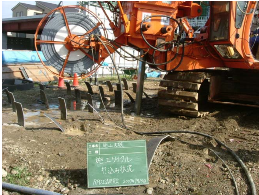
写真-1 施工事例
