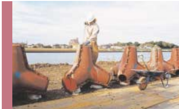
6 天端均し スペースング後、余盛をしてコンクリートの沈下がおさまってから行います。
