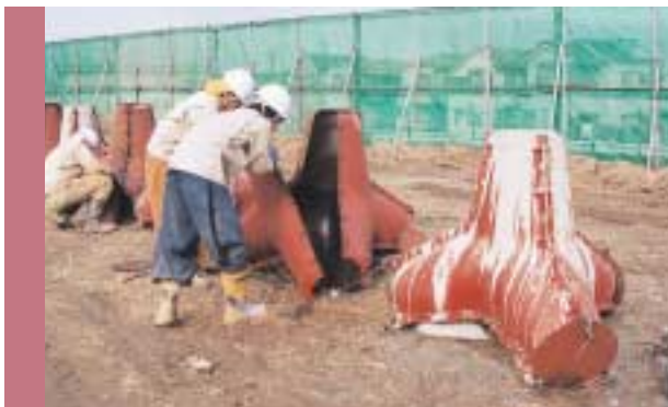
2 型枠組立 側枠を底枠に建込み、テーバーピンを打込み、コッターピンを挿入してコッターで締め付けます。
