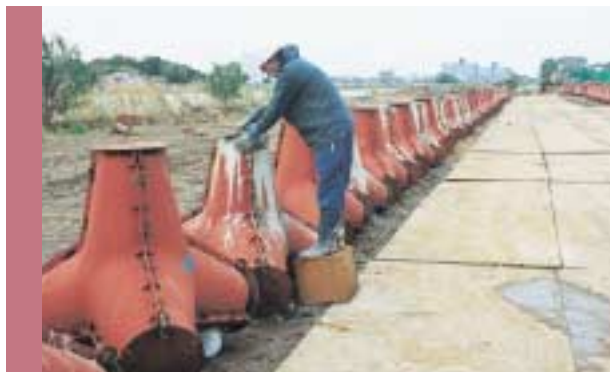
6 天端均し スペースング後、余盛をしてコンクリートの沈下がおさまってから行います。
