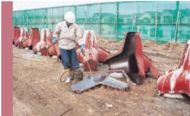
2 型枠組立 側枠を底枠に建込み、テーバーピンを打込み、コッターピンを挿入してコッターで締め付けます。
