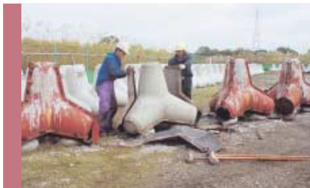
8 転置 コンクリートの所要強度が確保されてから行います。
