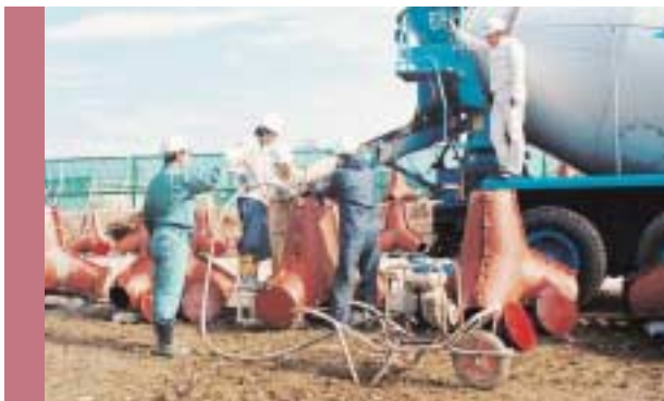
4 コンクリート打設 バイブレーターを使用し生コンクリートを十分締め固めます。
