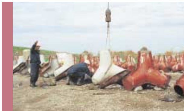
8 転置 コンクリートの所要強度が確保されてから行います。
