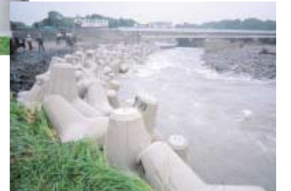
応急復旧完了
