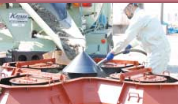
4 コンクリート打設
