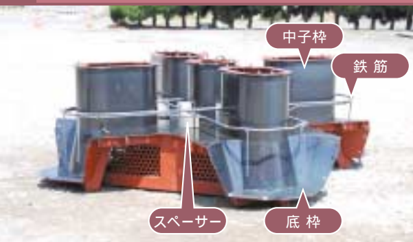
2 底枠・中子枠、鉄筋設置
