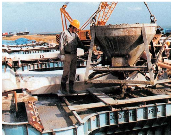
⑤コンクリート打設
