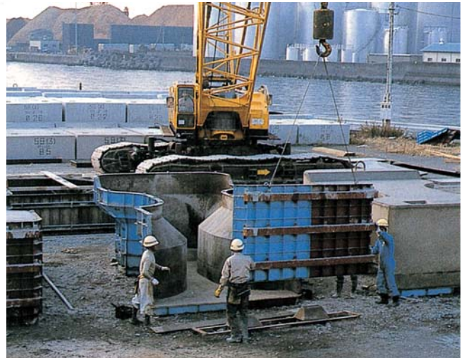
③型枠組立
