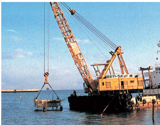
⑪イグラー据付
