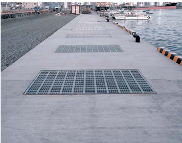
⑰グレーチング工
