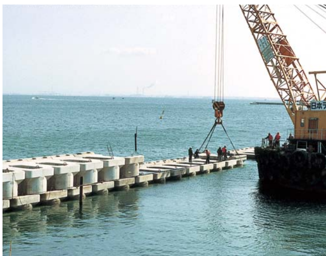
⑫イグラー据付
