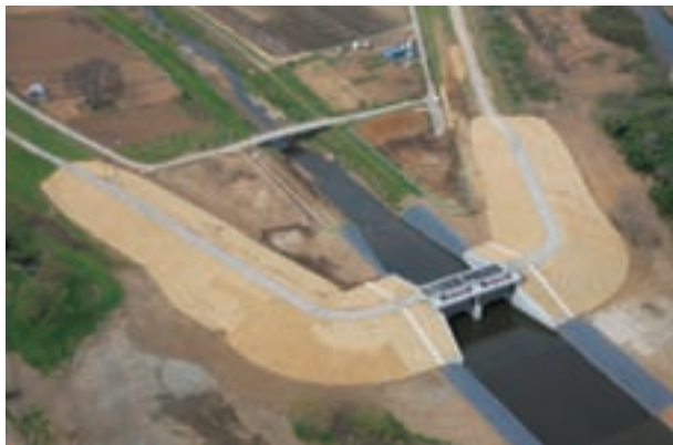
(発注者)国土交通省 関東地方整備局 (施工場所)埼玉県
