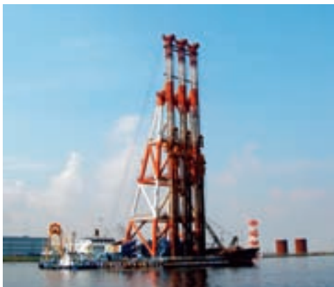
(発注者) 横浜市 (施工場所) 神奈川県横浜市
